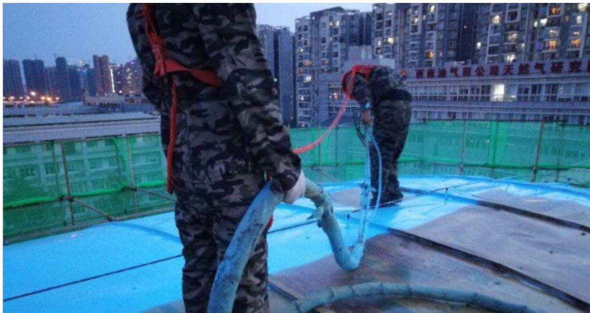
聚脲喷涂底材要怎么处理：喷涂聚脲施工质量的关键，可以分为金属底材以及混凝土底材。下面就介绍一下聚脲喷涂底材要怎么处理。1. 混凝土底材处理：对混凝土预制件进行抛丸处理或用角磨机和高压水枪等清理表面的灰尘浮渣。等底材完全干燥后用堵缝料进行表面找平，需要堵缝部位待堵缝料固化后用角磨机磨平。然后清理掉表面的污物刷涂或是辊涂一道配套底漆待用。底漆重涂长为24小时短为3小时。2. 金属底材处理：先将底材喷砂处理到，对于焊缝等缺陷部位用环氧腻子找平，使整个底材能够平滑过渡等环氧腻子固化后用角磨机磨平，然后清洁底材辊涂或是刷涂两道配套底漆。原形再现性好，涂层连续、致密，无接缝、无针眼，美观实用。我们聚脲防腐施工施工的特性就决定了材料在选取上要相互一致，这样才能更顺利的施工，我们在进行聚
