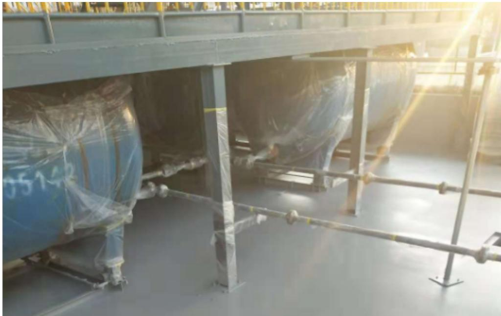
喷涂聚脲有非常快的反应速度，因此表面处理对聚脲工程的成败有很大影响。据不完全统计，聚脲工程的失败大约80%与底材处理不当有关。混凝土底材具有多孔、透气、透水且表面强度低等特点。这种多孔性会使很多污染物渗透进来，如果这些污染物没有清理掉，就会对聚脲工程造成极大的影响。而表面强度低会呈现一个脆弱的粘合界面，可能导致涂层脱落。这些问题造成聚脲与底材分离的潜在因素。所以，混凝土表面的浮浆和污染物，而且要修补混凝土表面的凹坑。混凝土基材的处理，首先要抛丸或打磨，增加粗糙度以提高附着力。然后修补表面的孔洞和裂缝。打扫灰尘，施工一道封闭底漆。混凝土基材宜采用强度高、渗透性好的底漆，常用的品种有聚氨酯、环氧树脂或丙烯酸树脂体系。公司生产工艺得到了长足的发展，优良的品质使我们的产品畅销全国各地。海南污水池聚脲防水
